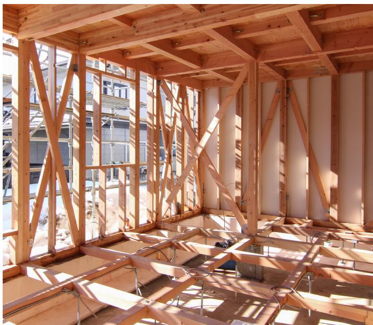
住まいを支える構造や暮らしやすさを向上させる断熱材など、完成後には見えなくなってしまう大切な部分。構造見学会では、実際に断熱材が一部施工された現場をご見学いただけます。
